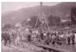
Construction d'un barrage sur l'étang de Gießen à Wolfach (1895).
