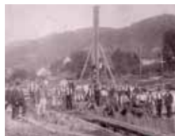
Bouw van de stuw bij de Gießenteich in Wolfach (1895).
