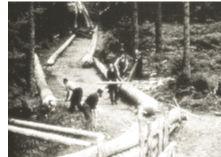
Eine mit Stammholz „bewehrte“ und erbaute Holz-Riese (Absbach im Holzwald bei Bad Rippoldsau 1977)
