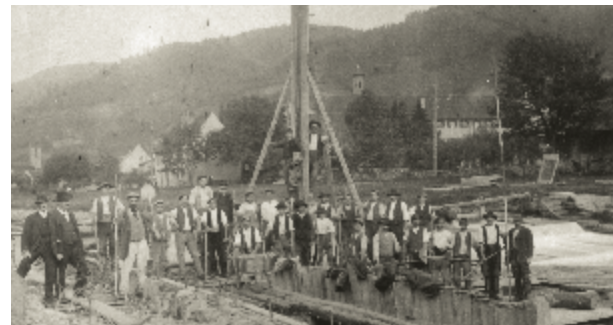
Wehrbau am Gießenteich in Wolfach (1895)
